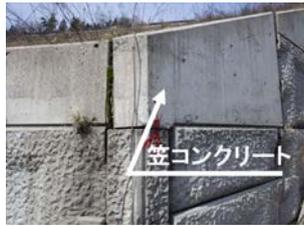
写真-2 笠コンクリートの傾斜
