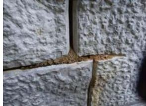
写真-3 目地の開きからの盛土材の漏出事例
