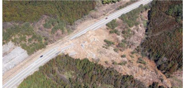
写真-1 盛土の被災事例（2007年能登半島地震）
