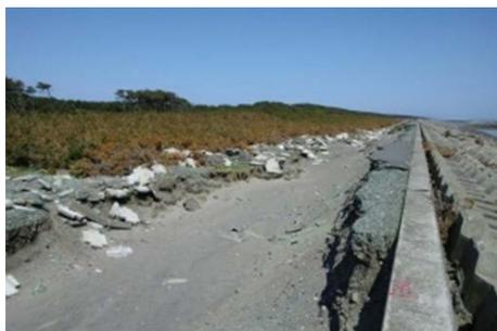
写真-1 内陸への津波遡上を阻止した海岸堤防背後の砂丘（青森県三沢海岸）
