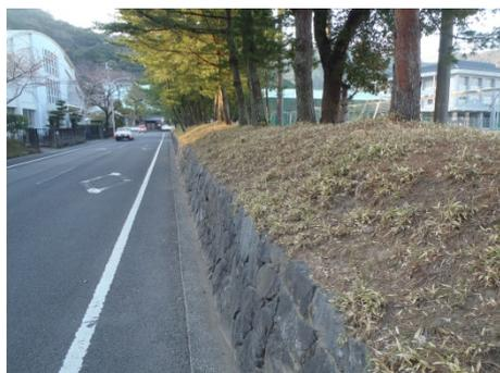
写真-2 宝永地震津波（1707年）後に構築され、現在も大事にされている古堤防（大分県佐伯市）
