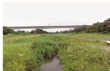
整備後1年、草木等の繁茂
