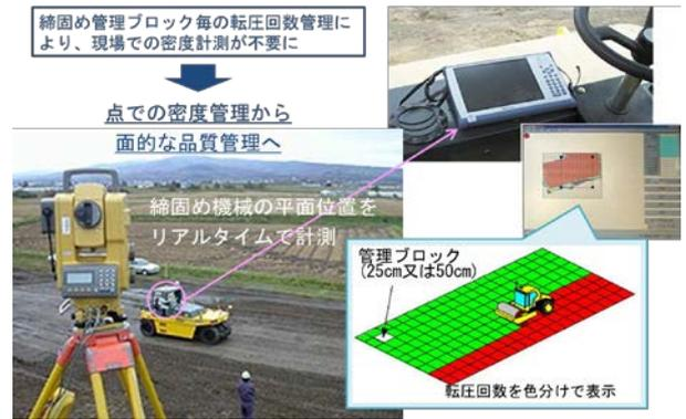
図-2 ローラの軌跡管理による締固め管理技術(例)
