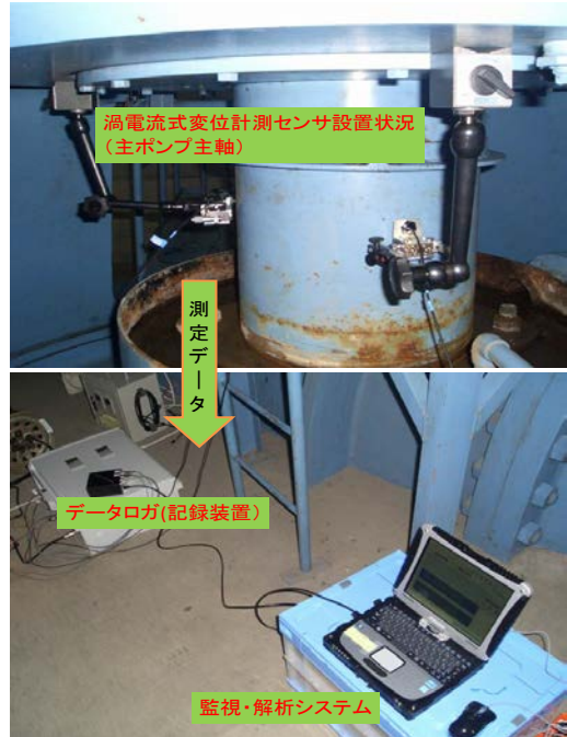
写真-3 河川ポンプの主軸振動解析
