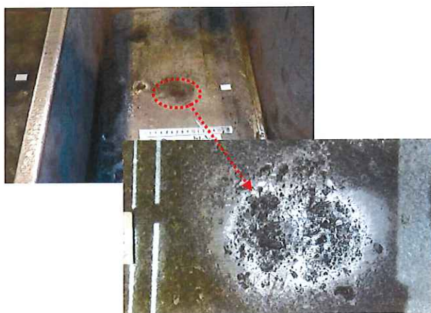
写真・10 2種ケレンの仕上がり状態（2回目）
