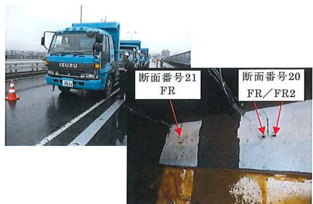
写真-6 静的載荷試験状況／ひずみゲージ設置状況
