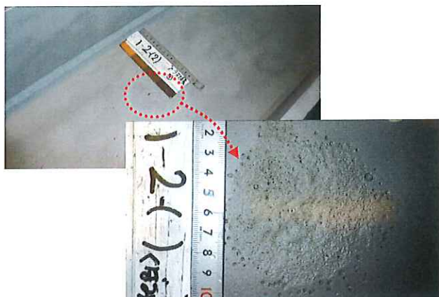
写真・9 1種ケレンの仕上がり状態（1回目）
