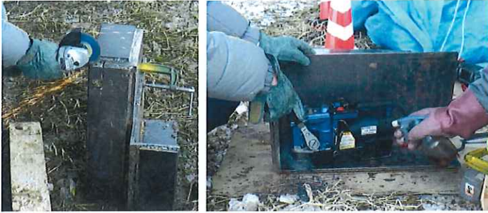
写真-5 当て板の切欠き加工
