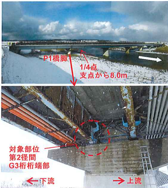
写真-2 対象橋梁
