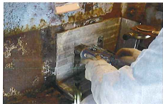
写真-4 ホールソーによる本体へのボルト孔の削孔
