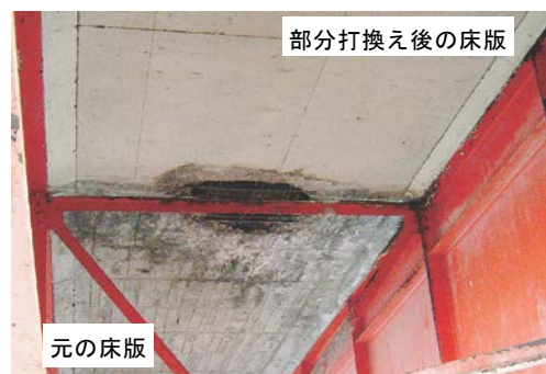
写真-1 部分打換えされたRC床版の打継目での疲労損傷事例 12)
