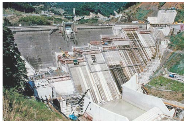
写真-1 萱瀬ダムの嵩上げ工事の状況
