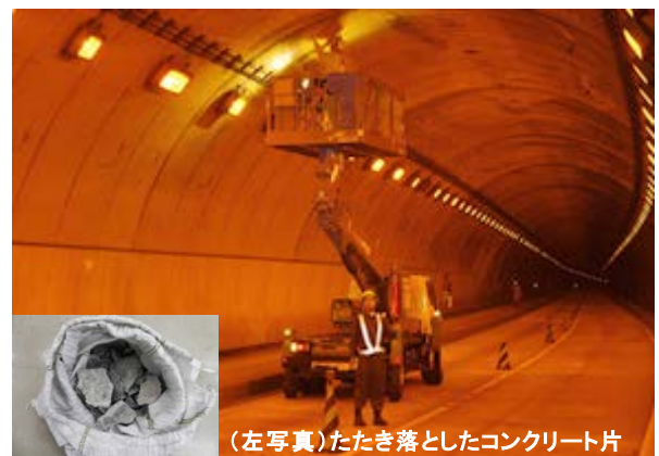
写真-2 トンネル点検状況（近接目視・打音）
