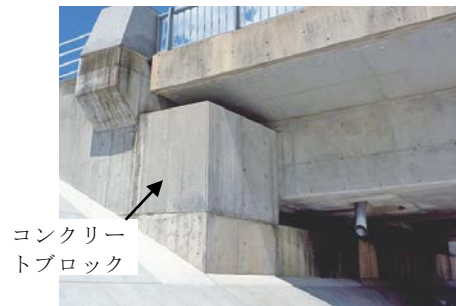
写真-3 遊間の側面を覆うコンクリートブロックの例
