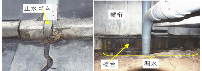
写真-7 歩車道境界の止水ゴムの損傷(左)とその直下の桁端部の漏水(右)
