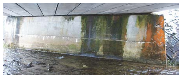
写真-4 橋台前面の漏水
