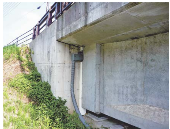
写真-14 2径間連続PCコンポ橋における試験的な設置 ポリエチレン製排水装置を100mmの遊間に挿入
