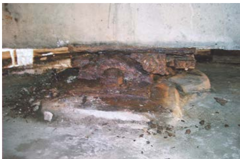
写真-11 橋脚上の鋼製支承の腐食
