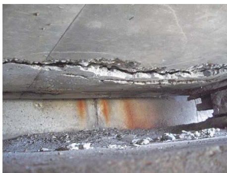
写真-10 PC箱桁端部下面の塩害事例
