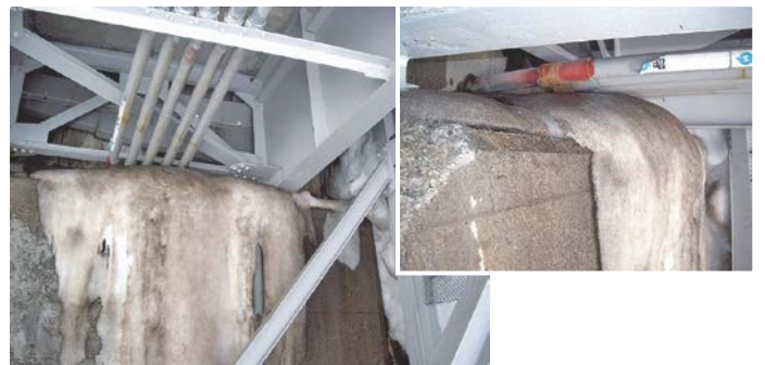
写真-9 伸縮装置からの漏水及び橋台背面からの流水の凍結 (鋼橋の例)
