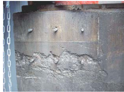
写真-12 落橋防止装置を取り外した時に見られた橋台前面の凍害
