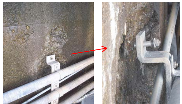
写真-13 橋台前面の凍害 (写真-9と同じ橋台)
