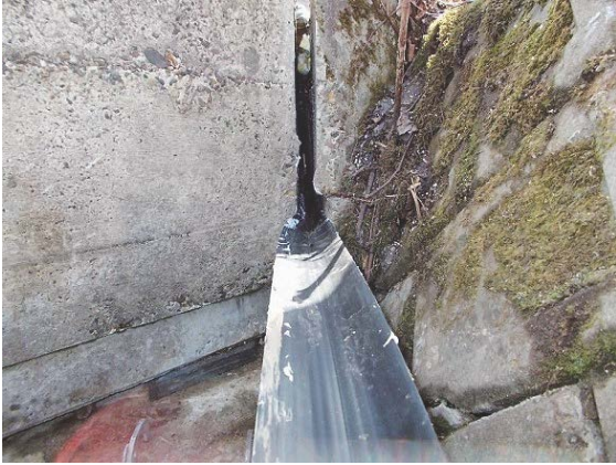
写真-15 単径間PC床版橋における試験的な設置 ゴム製排水装置を70mmの遊間に挿入
