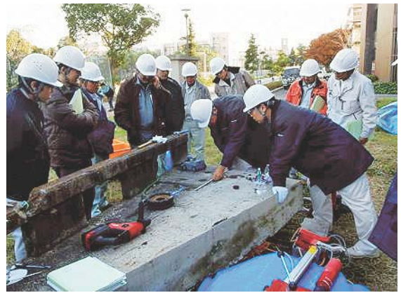
写真-1 点検演習状況
