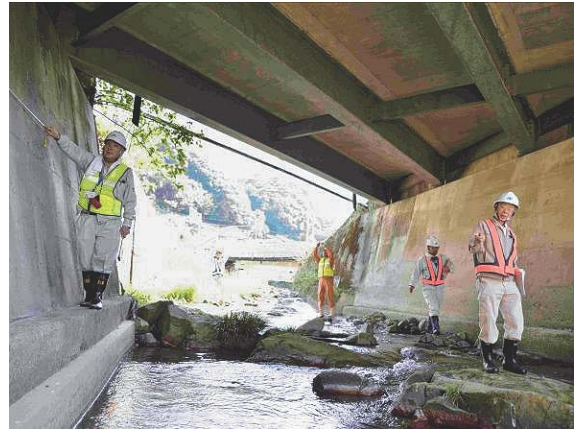
写真-3 点検状況
