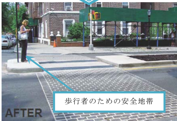
写真-3 安全地帯の整備による横断距離の短縮 (出典：ニューヨーク市提供資料 4) )
