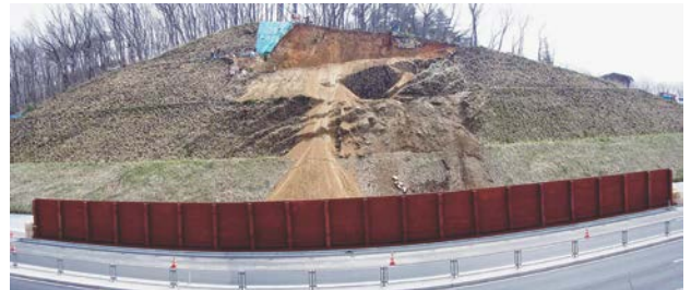
写真-2 供用開始後約1年の切土のり面の崩壊事例（管轄事務所提供）
