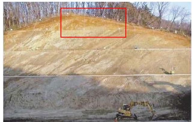
写真-3 上記のり面の施工中の写真（管轄事務所提供）赤枠付近が崩壊箇所
