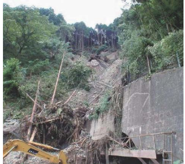
写真-1 トンネル坑口上方の谷型斜面の崩壊事例（管轄事務所提供）
