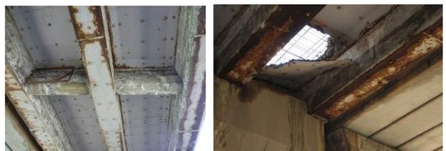
(e) 補修補強材料等により覆われ、その後床版内部の劣化状態の把握が困難である例
