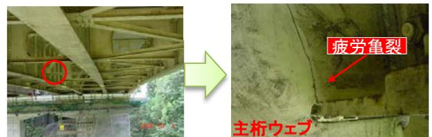
(a) 鋼橋主桁の疲労亀裂の例
