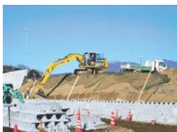
バックホウで材料投入
