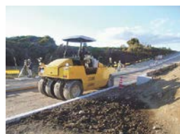
タイヤローラで締固め
