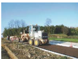
モータグレーダで敷均し
