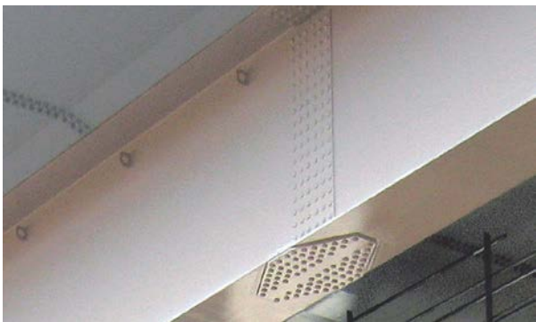
写真-1 主桁継手部
