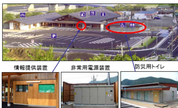
写真-4 道の駅の防災機能の整備事例
