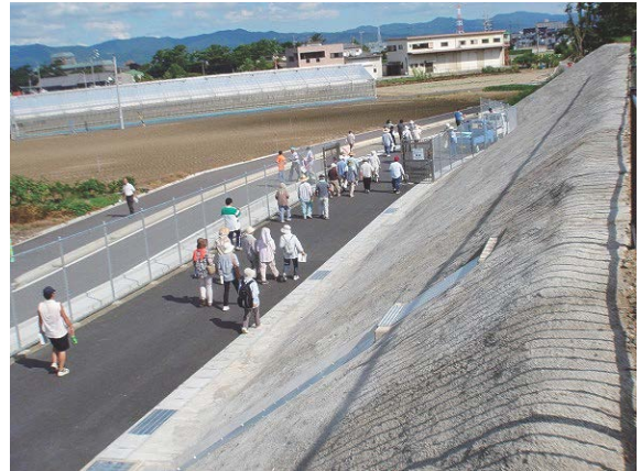
写真-2 緊急連絡路（国道23号豊橋バイパス）
