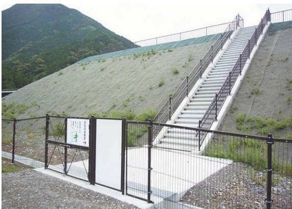
写真-1 緊急避難階段（紀勢自動車道）
