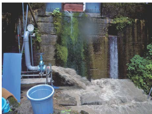
写真-4 潜行吸引式排砂管の現地実験状況 (上段：吸引部、中段：排砂管設置状況、 下段：下流排砂状況)
