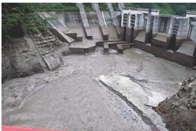
写真-2 宇奈月ダムにおける排砂状況 2) (上流から)
