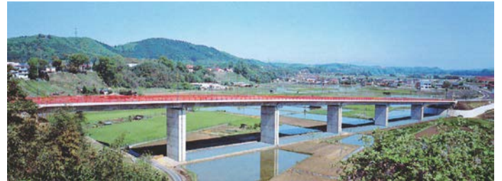
写真-2 高減衰積層ゴム支承を用いたわが国初のPC免震橋：山あげ大橋
