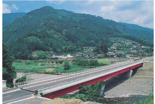
写真-1 わが国初の免震橋：宮川橋
