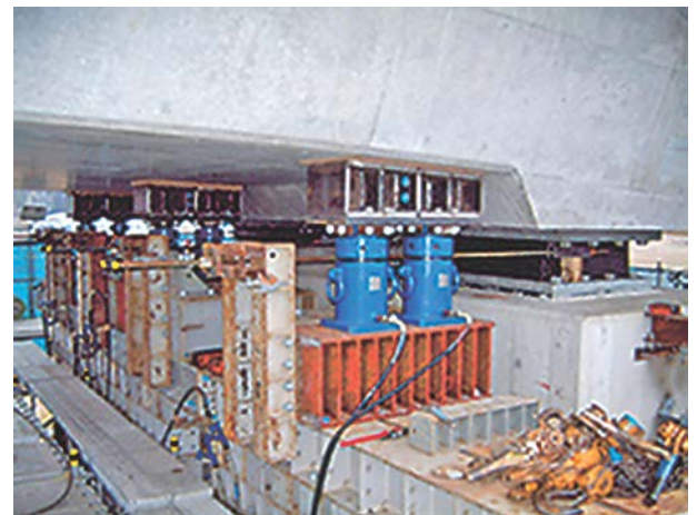
写真-3 免震支承の経年変化特性を調査するための既存支承の交換工事：山あげ大橋
