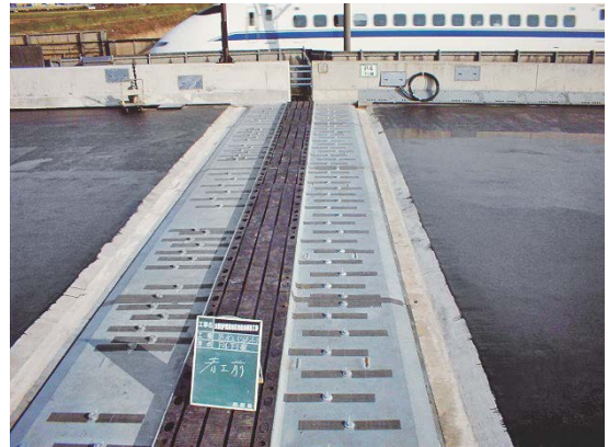
写真-4 免震橋用の伸縮装置：大変位吸収システム
