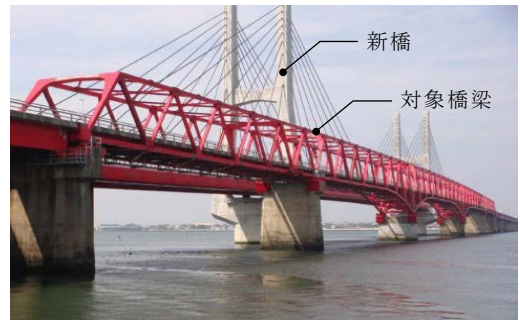
図-1 撤去前の対象橋梁（銚子大橋）
