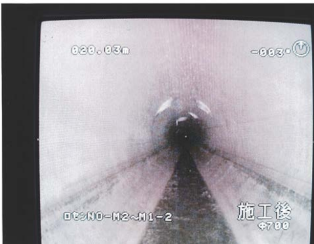
写真-6 改修後の排水路
