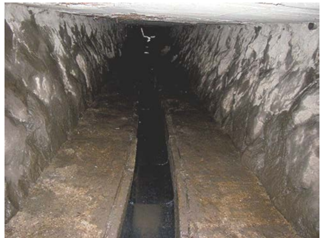
写真-4 雨水幹線の内部
