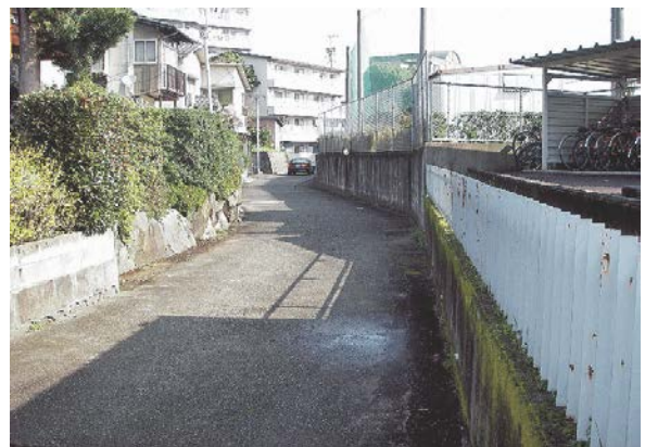
写真-1 下水道幹線上の生活道路
