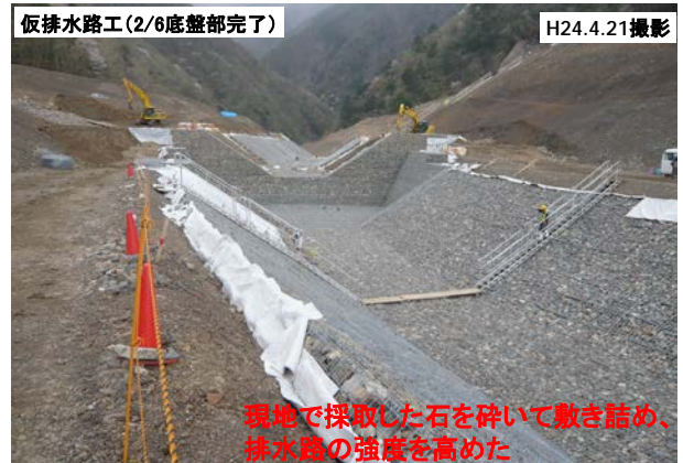
写真-3 赤谷地区における仮排水路の様子
