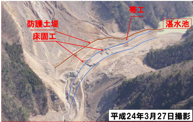
写真-2 赤谷地区における緊急工事の様子
