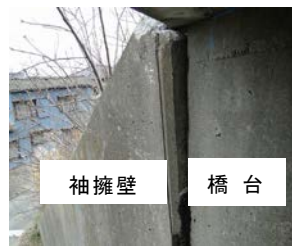
(擁壁の沈下)
