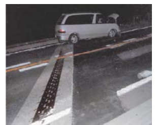
(路肩の段差に脱輪)
