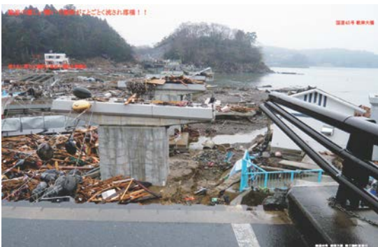
写真-1 国道45号歌津大橋（P2・P10径間の上部工流出）
