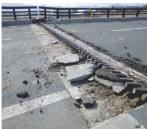
(伸縮装置部の段差)
