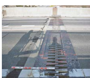
(伸縮装置の異常遊間)
