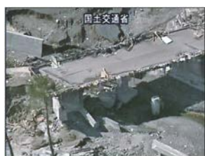
(国道45号波板橋)
