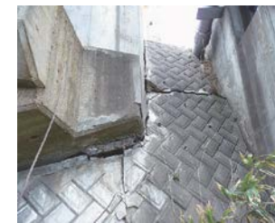
(ブロック積み段差)
