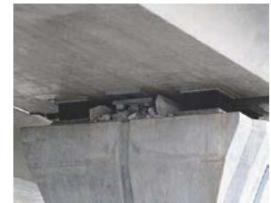
(変位制限構造損傷)
