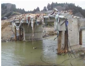
(国道45号二十一浜橋)
