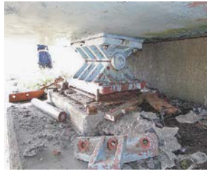
(ボルト破断・支承損傷)
