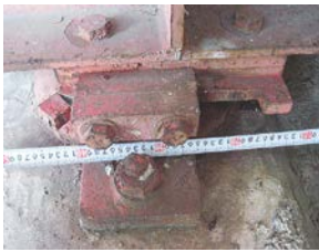
(移動制限装置破断)
