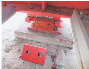
(サイドブロック損傷)
