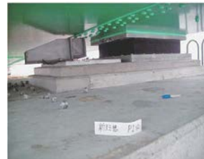
(ジョイントプロテクター損傷)
