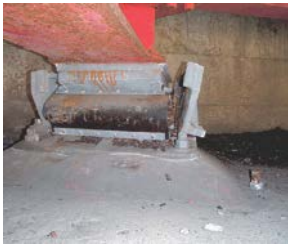
(ローラー沓の損傷)
