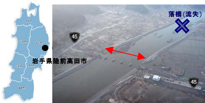
写真-10 国道45号気仙大橋 (上部工全て流出)
