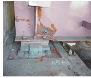
(鋼橋主桁端部座屈)
