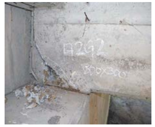
(RC橋主桁端部座屈)
