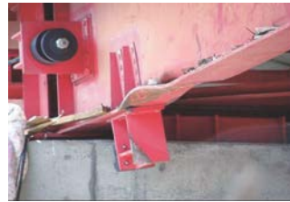
(流出物衝突に伴う主桁損傷)
