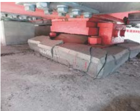
(台座コンクリートの損傷)
