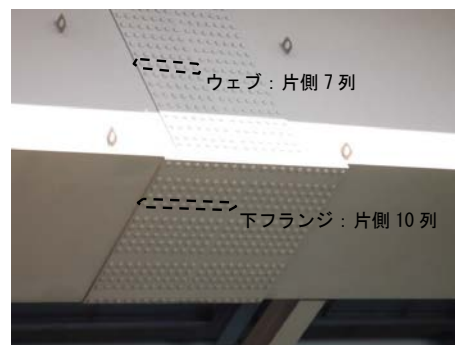
写真-1 多列ボルト継手の適用事例
