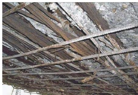
写真-4 グラウト充填不足による腐食事例(プレキャストセグメント箱桁橋での腐食・破断したPC鋼線)
