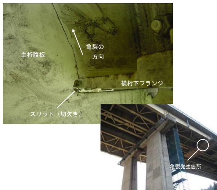
写真-1 主桁腹板に生じた疲労亀裂
