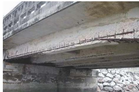
写真-3 コンクリート橋の塩害事例
