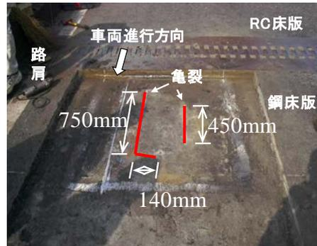
写真-2 鋼床版デッキプレートを貫通する疲労亀裂（舗装を除去したところ）
