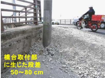
写真-4 橋台背面に著しい段差が生じた事例
