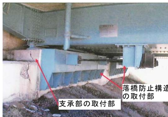
写真-2 支承部の取付部の損傷が落橋防止構造の取付部にまで及んだ事例（写真提供：福島市）
