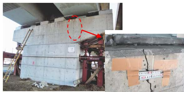
写真-3 地震時に橋脚の張出ばりが損傷した事例
