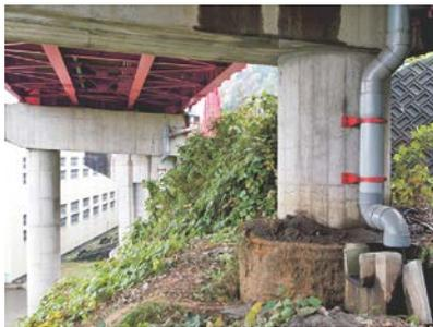
写真-5 斜面崩落により杭頭が露出した事例
