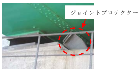
写真-5 ジョイントプロテクターが破損した事例
