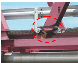
写真-4 トラス斜材の破断事例
