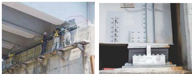
写真-1 検査路による近接点検 写真-2 仮支持のための主桁の補強の事例
