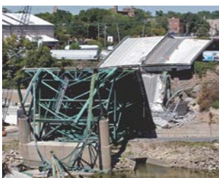
写真-3 崩落後のI-35W橋の全景（出典MN/DOT 9) ）
