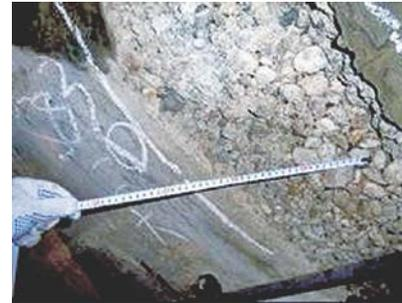
写真-1 骨材が露出している変状例
