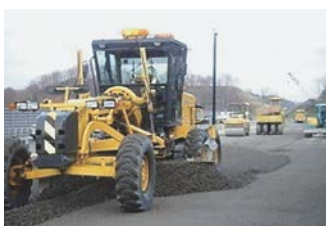
写真-4 ICT施工による削減例
