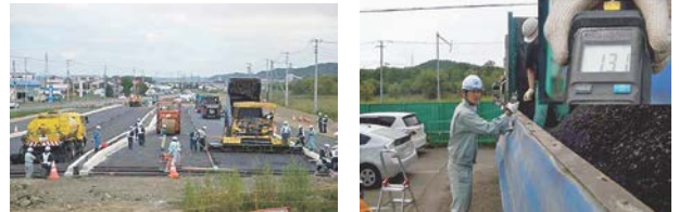
写真-2 中温化舗装施工状況 写真-3 出荷温度管理状況
