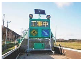
写真-5 ソーラー式機材の使用による削減例
