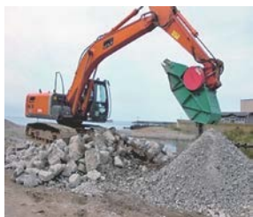
写真-6 現場内での再資源化
