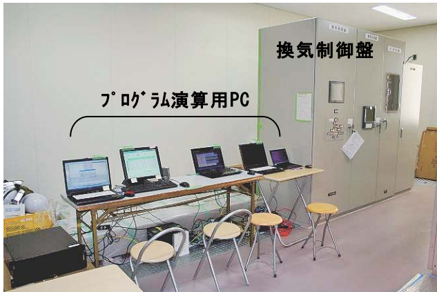
写真-1 電気室内の演算状況
