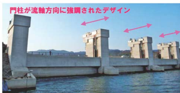
写真-3 上屋の無い水門の例 (宮城県北上川：月浜第一水門)
