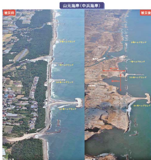
写真-1 津波による海岸線侵食状況
