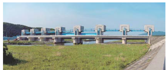
図-3 津軽石川水門（宮古市、写真は震災前）
