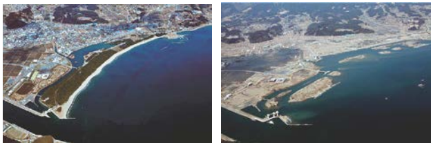
平成22年3月14日撮影 平成23年3月29日撮影 図-1 高田海岸（陸前高田市）
