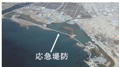
図-5 応急復旧状況 高田海岸（陸前高田市）
