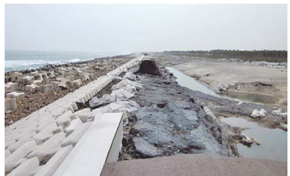
写真-1 裏法尻部における洗掘の状況 (宮城県岩沼市蒲崎海岸)
