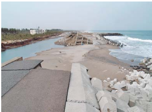
写真-2 全壊した三面張り構造の海岸堤防 (宮城県岩沼市二ノ倉海岸)
