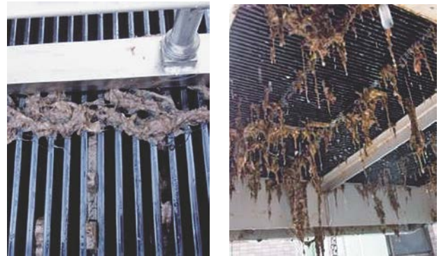
写真-1 膜の付着物（平膜タイプ） 左：膜上面 右：膜下面
