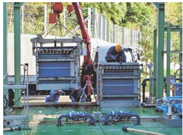
写真-2 膜間付着物の清掃作業（平膜）
