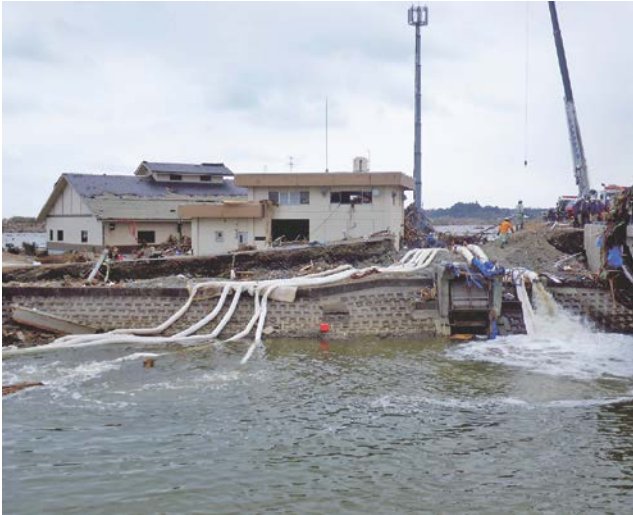
写真-4 相馬市における排水作業状況
