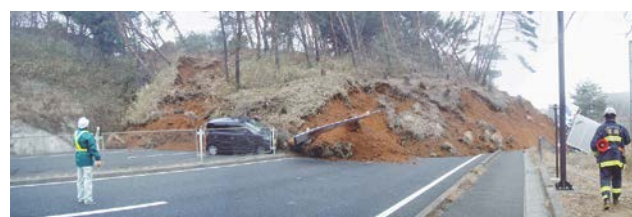
写真-1 国道4号伏拝地区の被災状況
