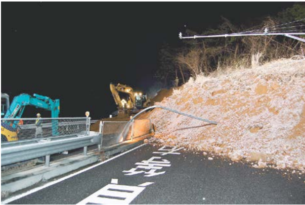
写真-2 土砂撤去作業の状況 (中央分離帯左側が下り線)
