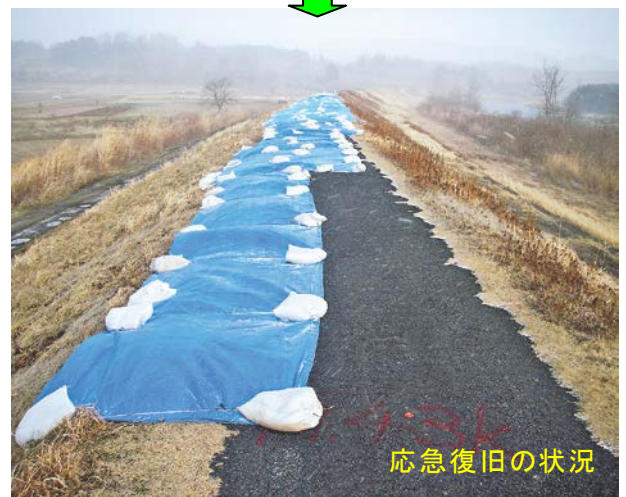
写真-6 阿武隈川の被災・復旧状況
