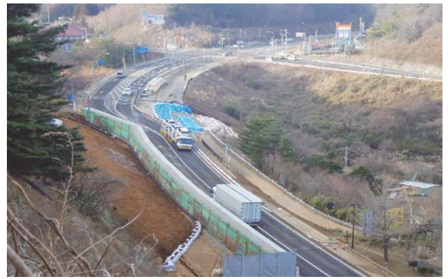
写真-3 暫定2車線で交通開放した国道4号 (左側が上り線、写真奥が伏拝交差点)
