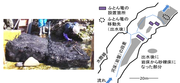
図-8 礫を詰めたふとん箆(左)、ふとん箆の設置箇所の概要(右)
