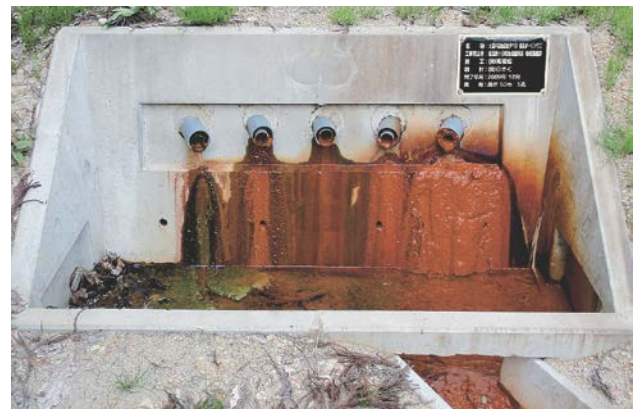
写真-1 横ボーリング集水管の閉塞状況
