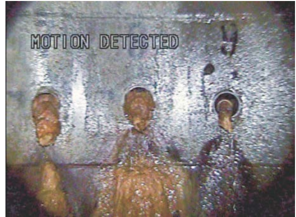
写真-4 集水管孔口の状況
