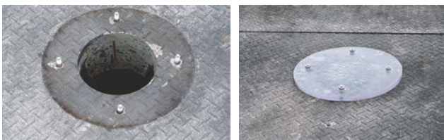
写真-3 点検用カメラ挿入穴
