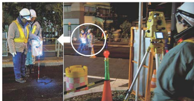
図-6 プリズム方式による計測状況
