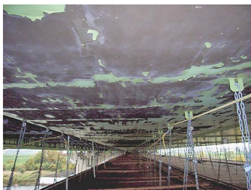
写真-2 塗膜はがれの状況
