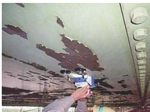
写真-3 塗膜断面調査
