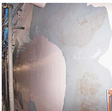
写真-1 塗膜はがれの状況
