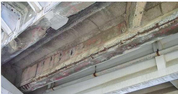
写真-1 PC桁端部の塩害劣化
