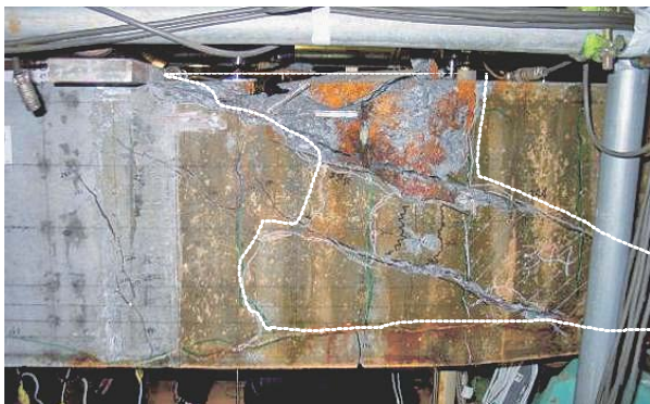
写真-4 載荷終了後のかぶりコンクリートの剥離・剥落（白破線の範囲）
