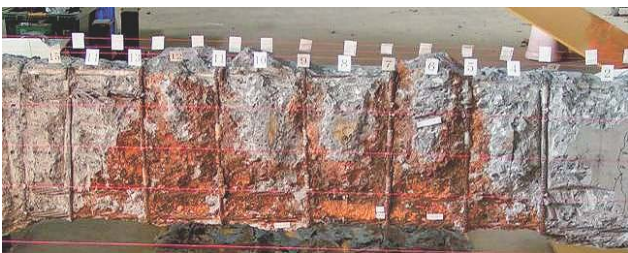
写真-6 荷役後のかぶりコンクリート撤去状況
