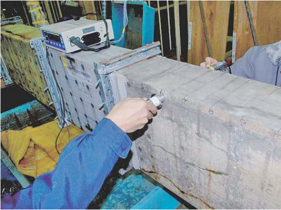
写真-5 超音波伝播速度の計測状況
