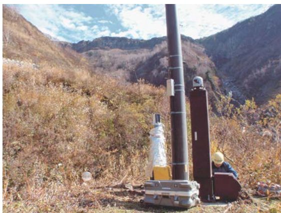
写真-4 地上設置型レーザースキャナによる斜面の変形計測
