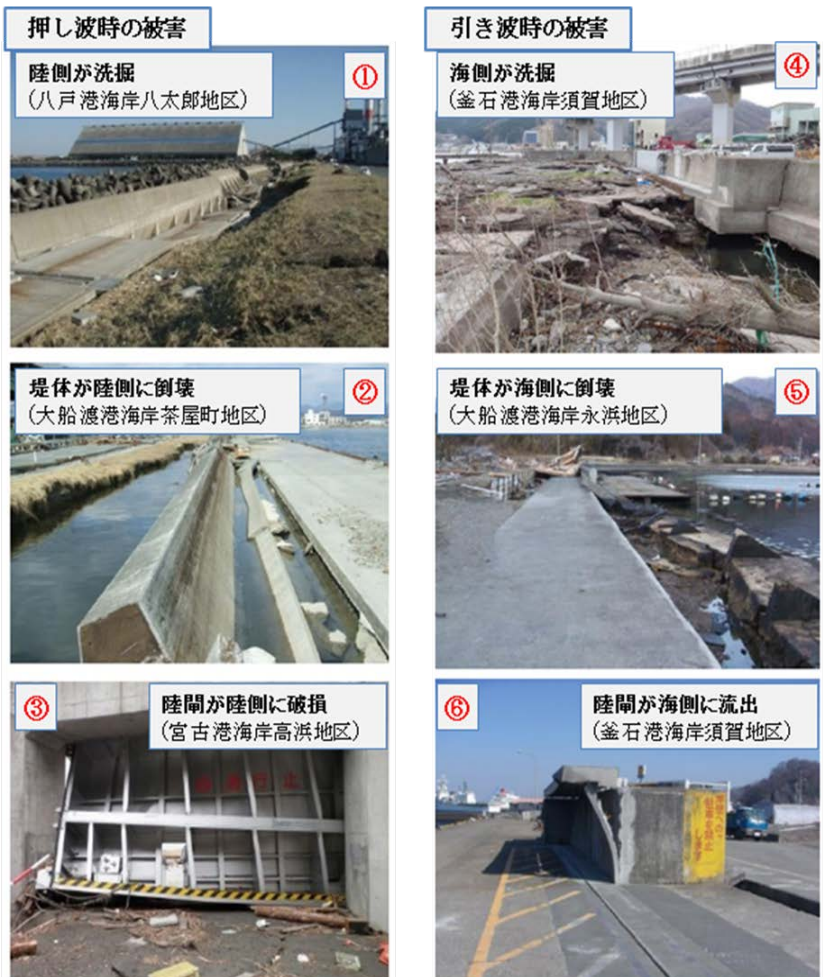
写真-1 海岸保全施設被害 (参考文献3) より
