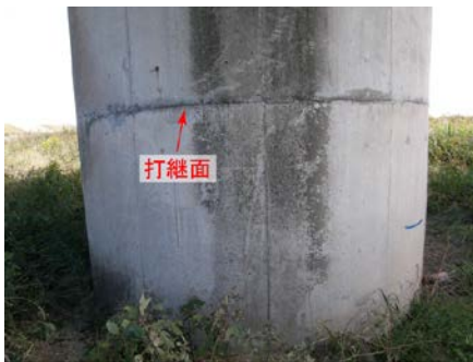
(b) 東北地方太平洋沖地震後の状況
