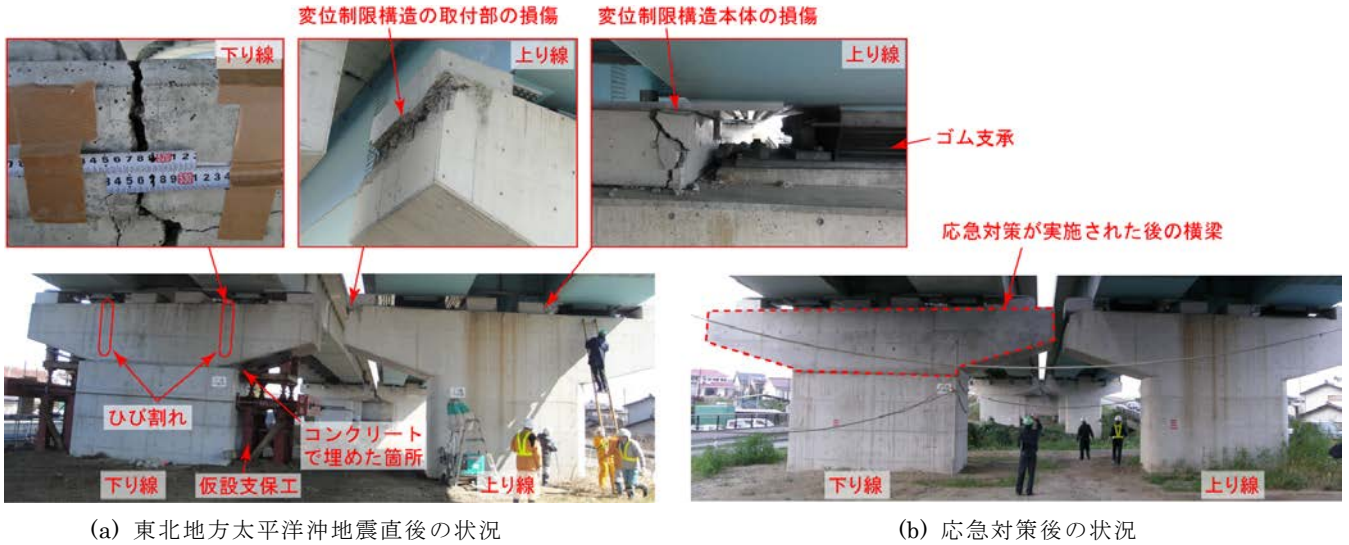
写真-5 張出し部付け根付近のひび割れまたは変位制限構造に損傷が生じたT型のRC橋脚
