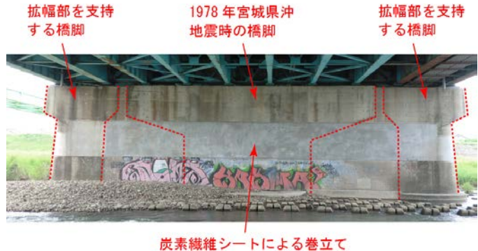
(b) 東北地方太平洋沖地震後の状況
