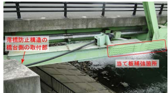
(b) 応急対策後の状況
