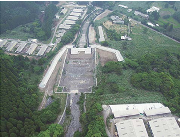
写真-4 庄内川上流域での越流防止対策
