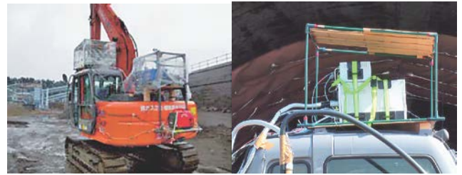
写真-8 雨・直射日光対策状況
