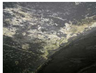
写真-1 肩部の縦断ひび割れ 写真-2 材料劣化部の例
