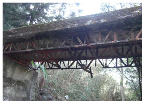
写真-1 撤去前のトラス橋（東かがわ市）
