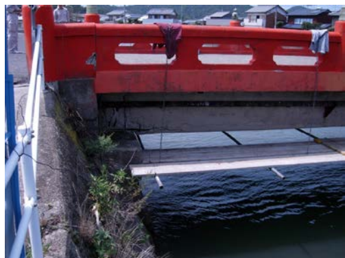
写真-5 橋の中央で4mm程度下がった橋（橋長13.6m）
