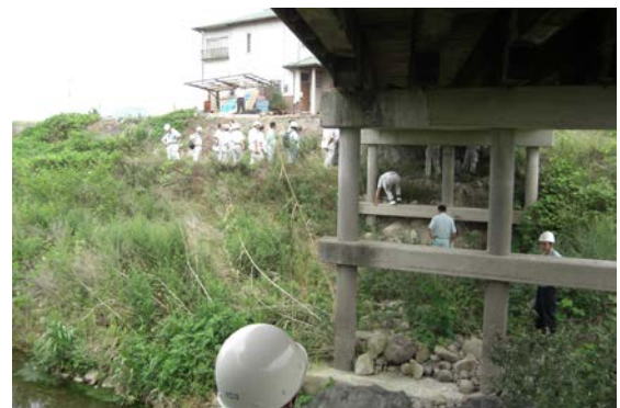
写真-2 解体移設された木橋（第10回講座）
