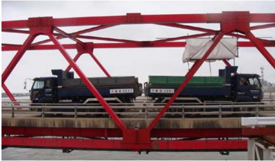
図-5 荷重車載荷の状況
