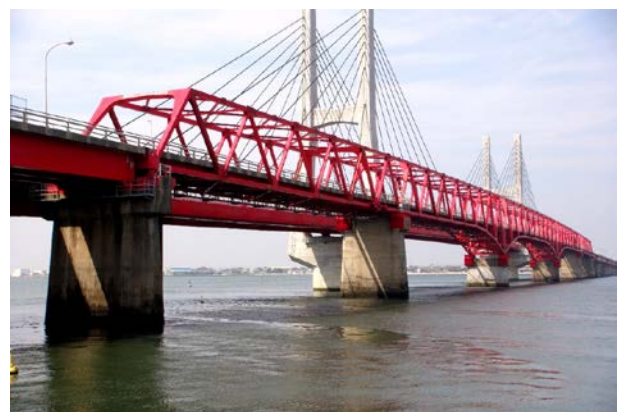
図-2 撤去前の対象橋梁(手前)と新橋(奥)
